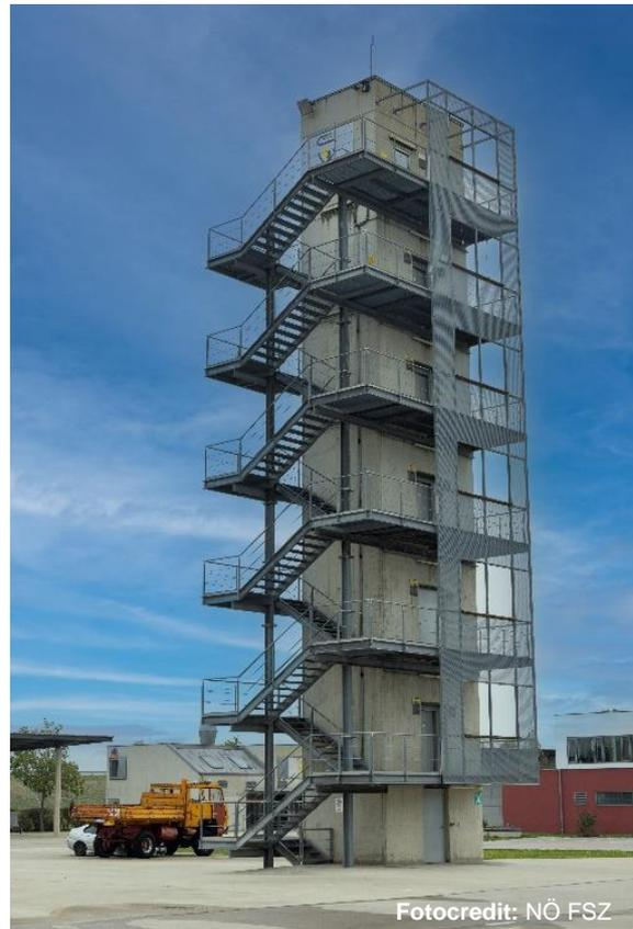
Eine vorgesetzte Fassade mit Fensteröffnungen bietet die Möglichkeit, das Anleitern mit verschiedenen im Feuerwehrdienst gebräuchlichen Leitern, zu üben. Das Aussteigen durch eine Fensteröffnung ist auch über eine Schiebleiter möglich.
